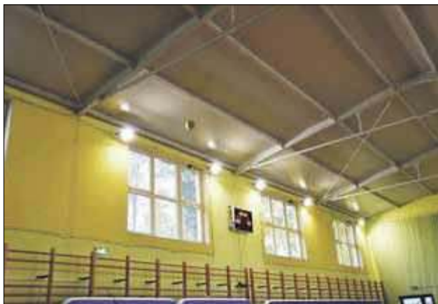
Budynek Szkoły Podstawowej w Rzeczy doczekał się modernizacji wentylacji oraz systemu grzewczego. Wymieniono tam także oświetlenie
