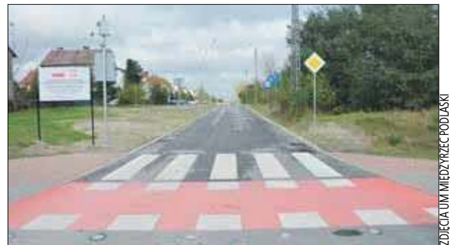
Bezpiecznie i komfortowo jest już teraz na ulicy Modrzewiowej, która ma całkowicie nową nawierzchnię
