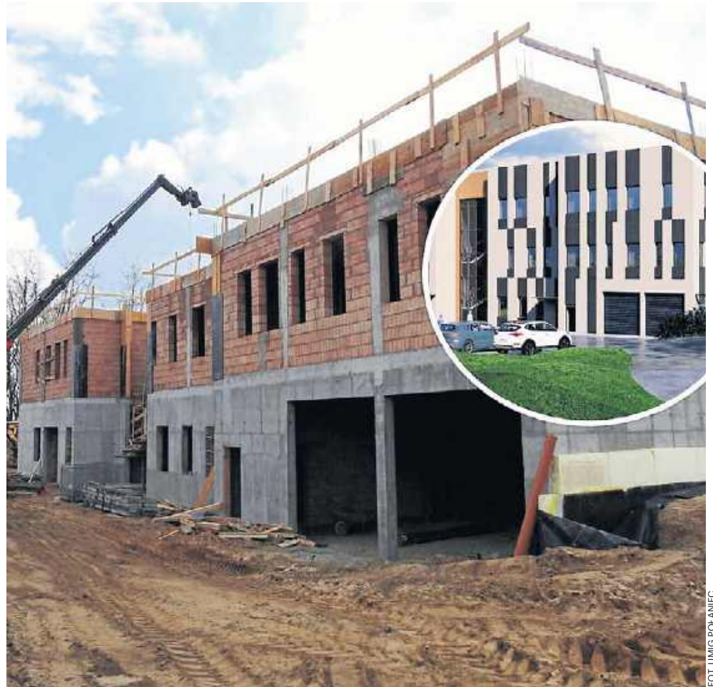
Prace przy budowie przychodni w Połaniu. Widać już drugą kondygnację.
