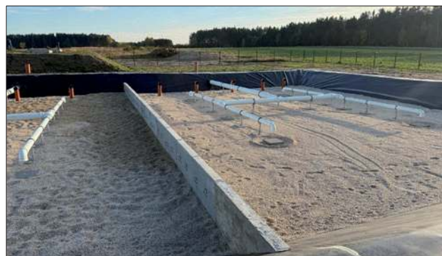
Fot. 3. Tomawa, gmina Łęki Szlacheckie – filtry pionowe pasywnej oczyszczalni wykonanej w formule „zaprojektuj i wybuduj”. Źródło: RDLS
