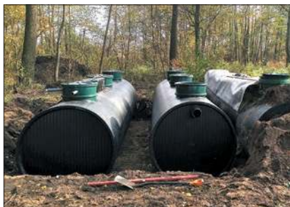
Fot. 2. Modułowa oczyszczalnia osiedlowa (do 200 RLM) podczas montażu. Źródło: Bamartech
