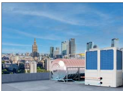
Fot. 2. Rewersyjny (z funkcją pompy ciepła) agregat wody lodowej chłodzony powietrzem z czynnikiem R32, przeznaczony do obsługi średnich i większych budynków komercyjnych, szczególnie zlokalizowanych w miastach (50–140 kW wydajności chłodniczej z pojedynczego agregatu) Źródło: Midea
