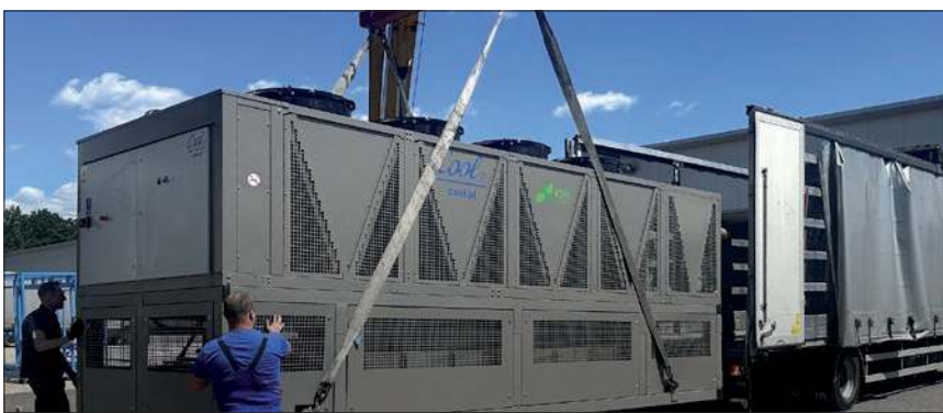
Fot. 4. Agregat wody lodowej chłodzony powietrzem przemysłowy, pracujący z czynnikiem chłodniczym R290 (GWP = 1) Źródło: COOL
