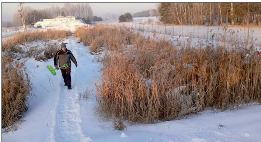
Fot. 1. Udrzynek, gmina Brańszczyk – filtr hydrofitowy podczas zimowej eksploatacji. Próbką z 7 stycznia 2026 r.: BZT, 3 mg/l, ChZT 51 mg/l, zawiesina 3,4 mg/l Źródło: RDLS
