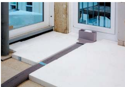
Fot. 5. Układanie kanału płaskiego w warstwie izolacji Źródło: Zehnder
