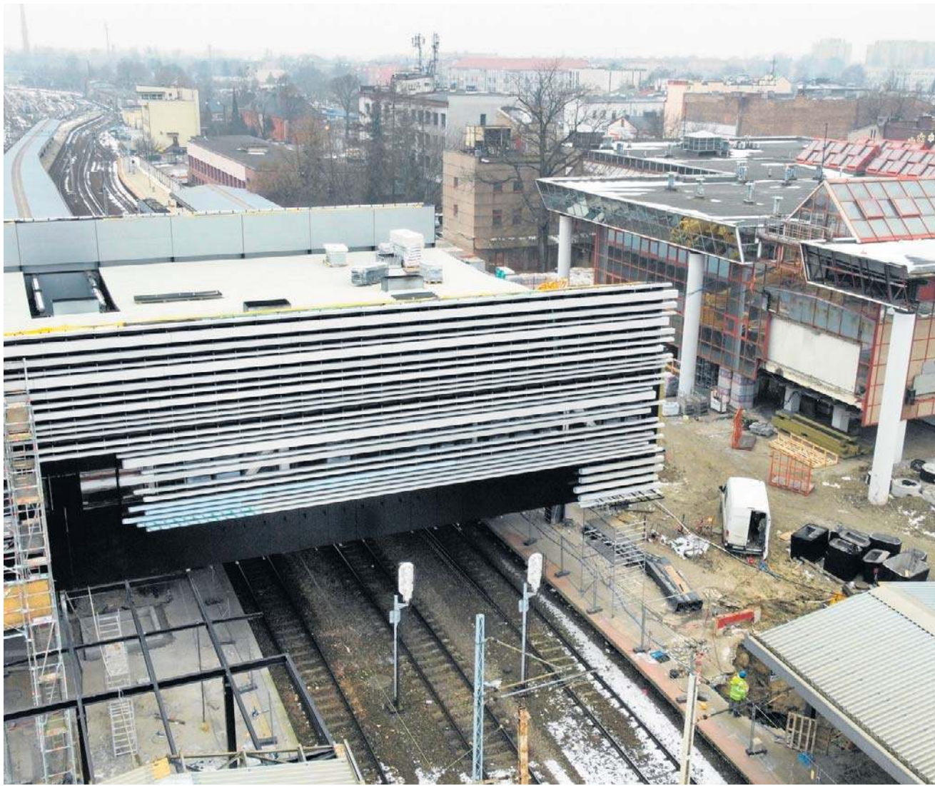
Przebudowa dworca PKP w Częstochowie. Trwa montaż elementów elewacji
