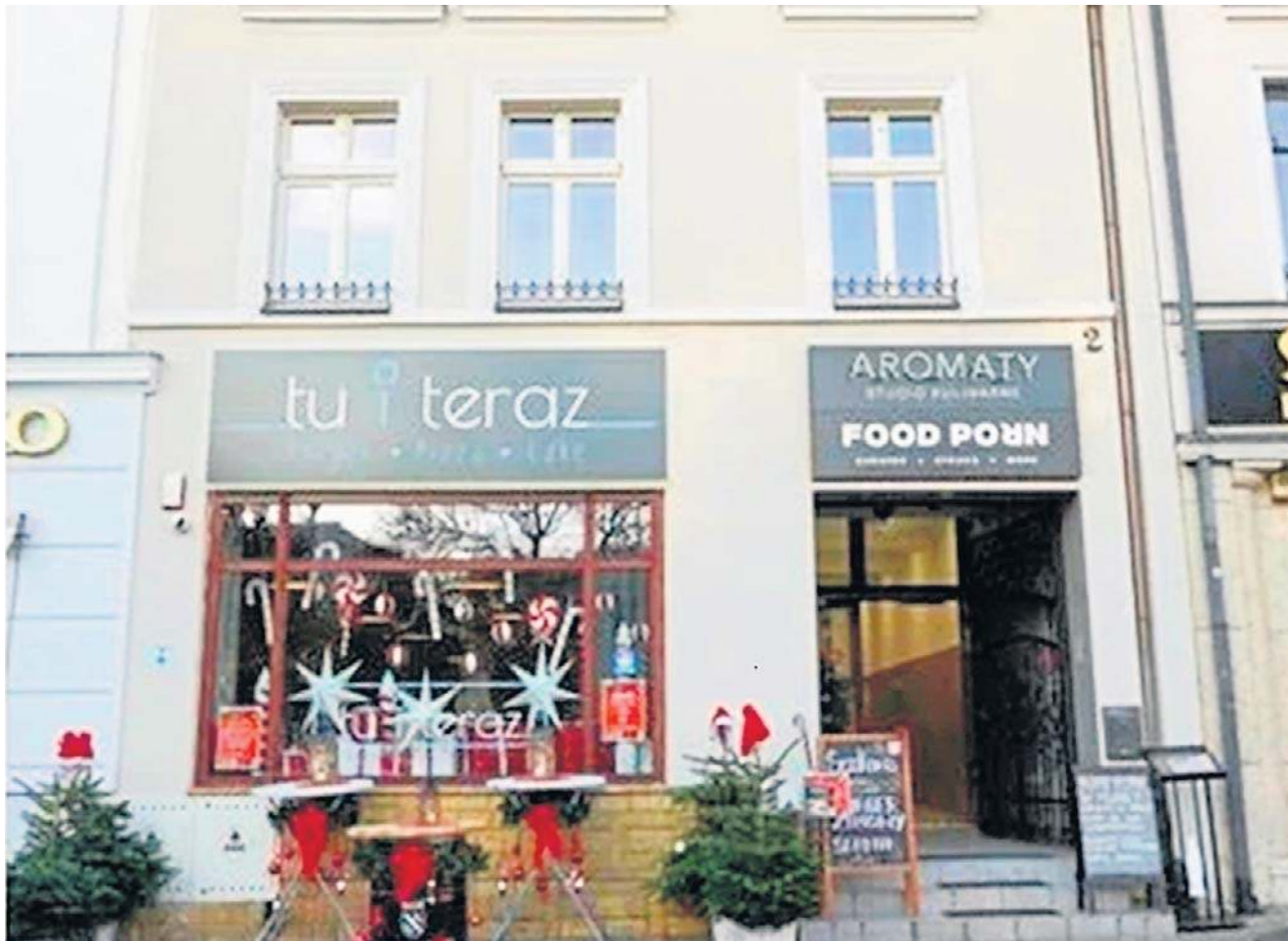
Jedna z nowych elewacji domu na rybnickiej starówce. Z przestrzenią współgrają też sklepowe witryny
