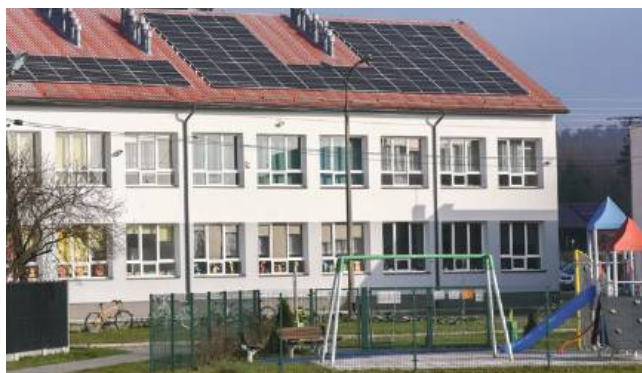
Szkoła w Tereszpolu-Kukielekach po termomodernizacji wraz z instalacją fotowoltaiczną.
