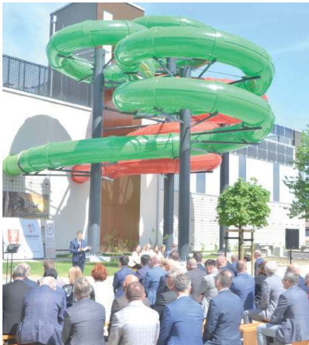
Wielkie kolorowe zjeżdżalnie, które widać z daleka, póki co cieszą tylko oko. Zjazd prowadzi do...recepji i jest zamurowany. Zjeżdżalnia ma zostać uruchomiona dopiero po wykonaniu 2 etapu i przeniesieniu recepcji na front budynku
