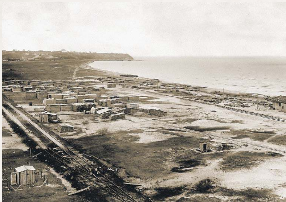
Teren przyszłego portu w Gdyni, lata 1921-1922
