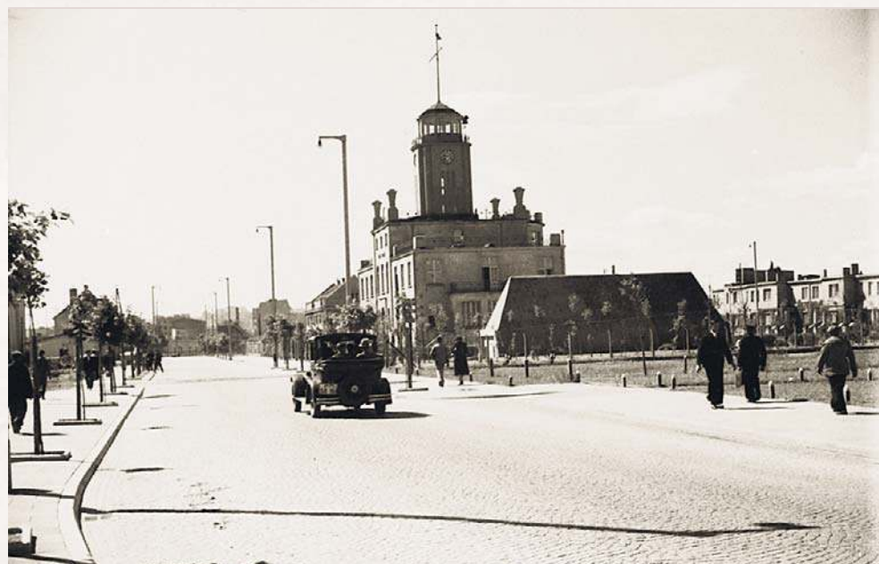
Urząd Morski przy ul. Centralnej (ob. Chrzanowskiego) w Gdyni
