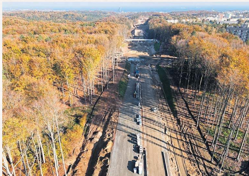
W 2025 r. rozpoczęła się budowa Obwodnicy Witomina
