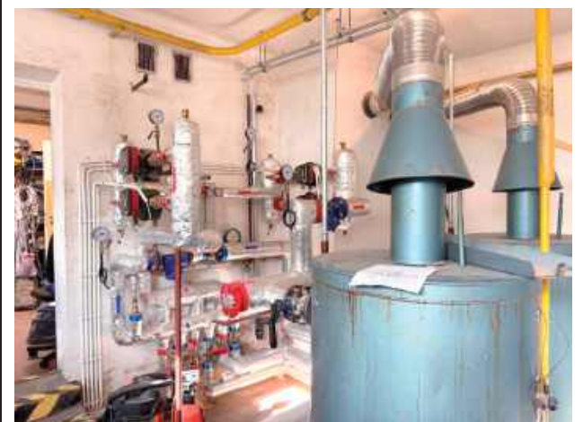
Remont kotłowni szkoły w Januszówce
