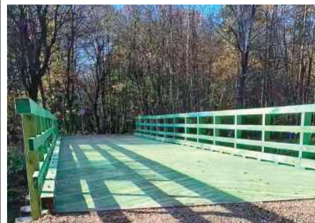
Wyremontowany most na kanale Wieprz-Krzna
