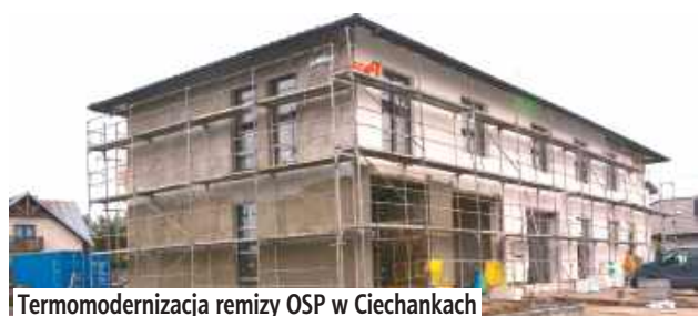
Termomodernizacja remizy OSP w Ciechankach
