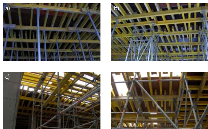
Fot. 1. Najczęstsze sposoby podpierania konstrukcji podczas realizacji budownictwa kubaturowego: a) regulowane teleskopowe podpory, b) wieże nośne, c) rusztowania podporowe
