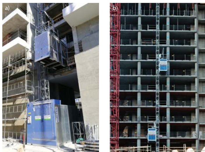
Fot. 4. Dźwig GEDA BL 2000: a) wersja jednokabinowa (tzw. Single), b) wersja dwukabinowa (tzw. Twin)
