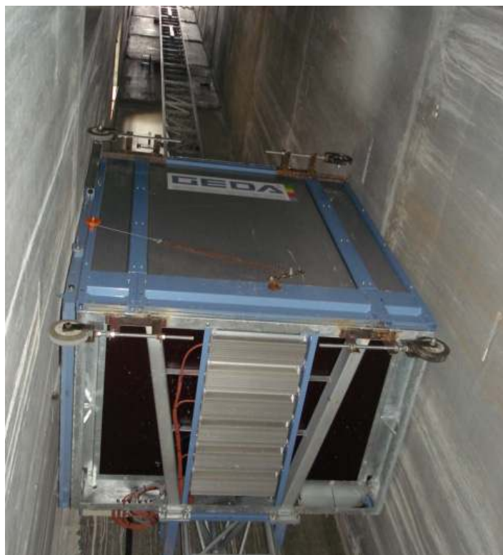
Fot. 2. Dźwig towarowo – osobowy wewnętrzny firmy GEDA (pracujący w szkielecie windowym)
