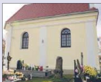
Roboty remontowo-konserwatorskie przy kaplicy cmentarnej na cmentarzu parafialnym w Czerminie
