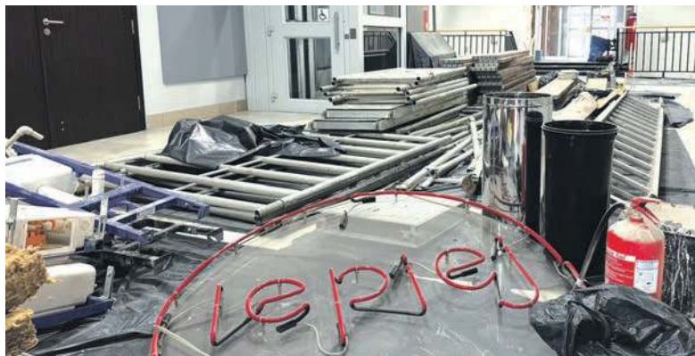
Zmiany jakie spowoduje remont będą kolosalne
