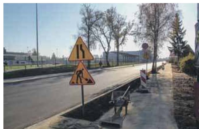
Remont na ul. Kolejowej już się rozpoczął.
