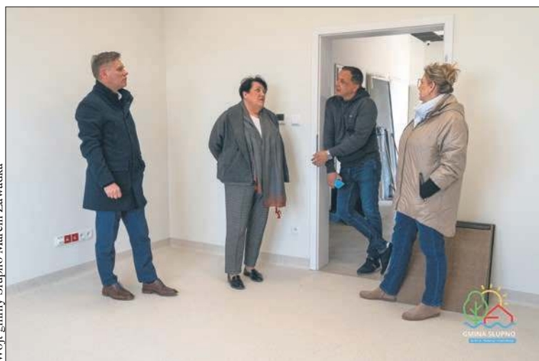
Budowa Centrum Opiekuńczo-Mieszkalnego w Gulczewie
