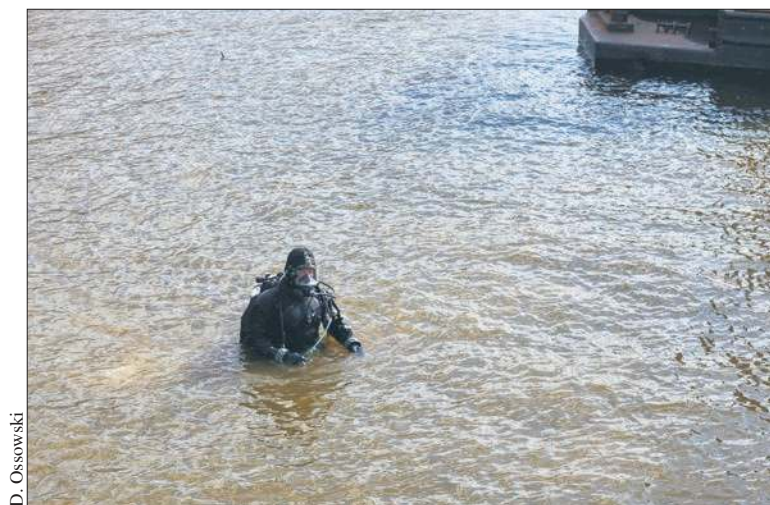
Nurkowie oczyszczali teren przy rampie
