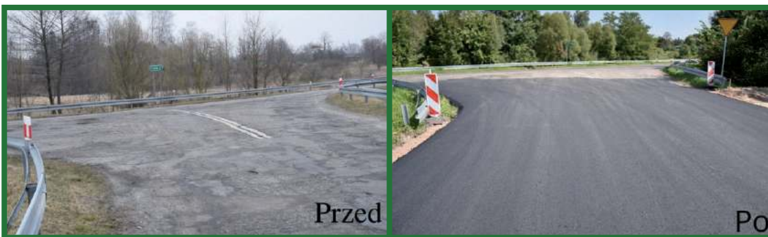
Przebudowa drogi powiatowej na odcinku Nowiny-Rudka
