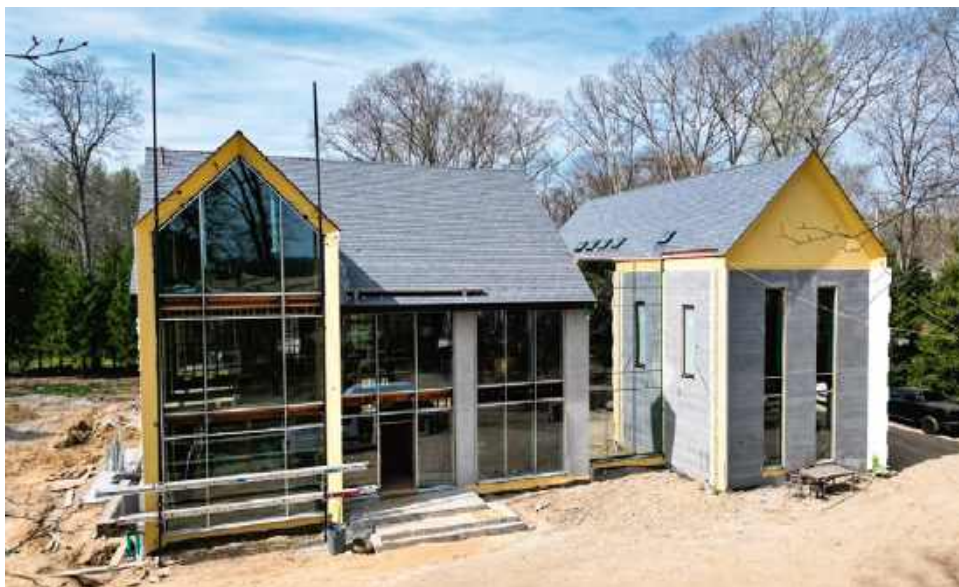
📍 W przegrodach z klocków ze styropianu nie ma ryzyka powstawania mostków cieplnych, bo zachowana jest tu ciągłość izolacji. IZODOM 2000 POLSKA
