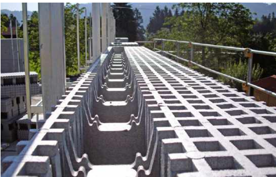
Ściany z kształtek styropianowych buduje się warstwami, podobnie jak konstrukcje z klocków. Następnie w ich środku umieszcza się zbrojenie i zalewa betonem. IZODOM 2000 POLSKA
