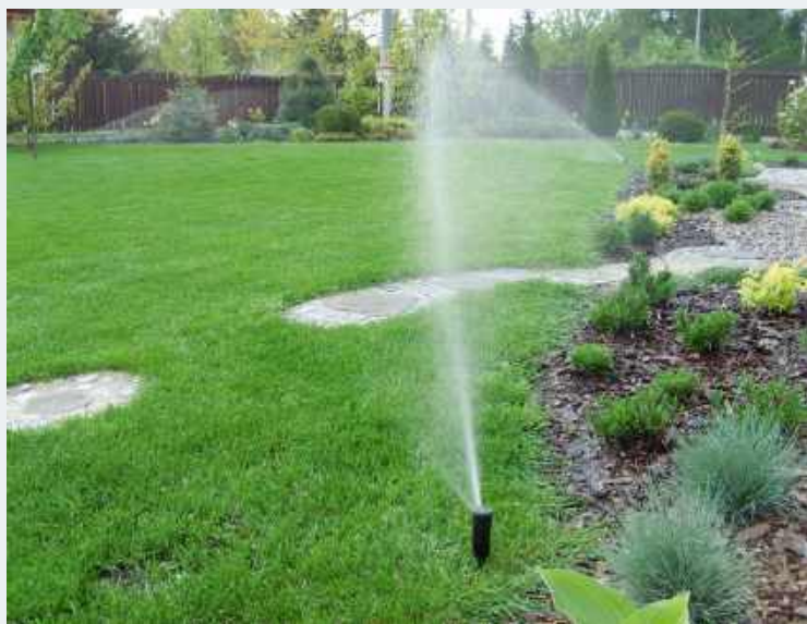
Do podlewania trawnika wykorzystuje się wynurzalne zraszacze rotacyjne.
