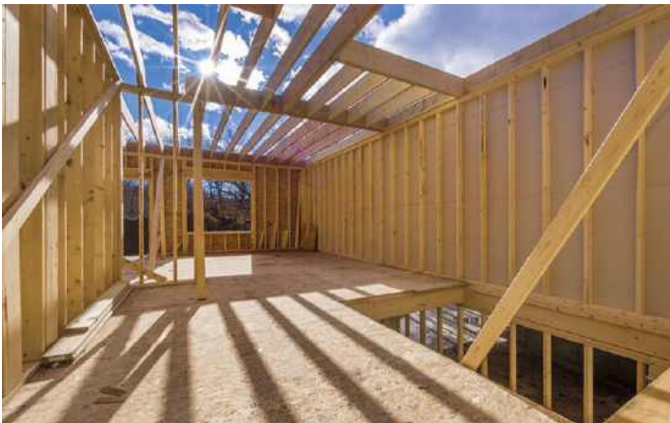
📍 Kluczowym elementem kanadyjczyka jest drewniany szkielet, który wypełnia się szczelnie wełną mineralną i ostonia wybraną okładziną. JAF POLSKA, TEKUM
