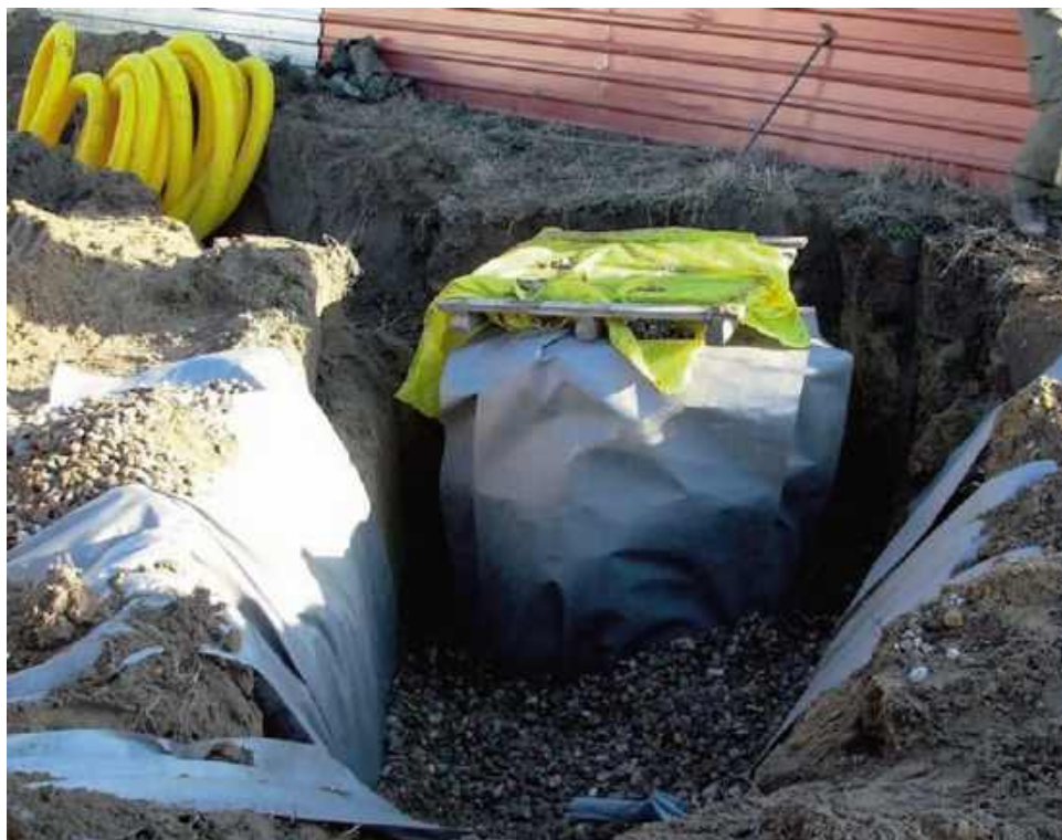
📍 Studnia chłonna musi być posadowiona przynajmniej 1,5 m powyżej wód gruntowych. GREEN WATER
