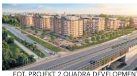
FOT. PROJEKT 2 QUADRA DEVELOPMENT
