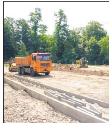
Budowa boiska w Dobrkowie.
