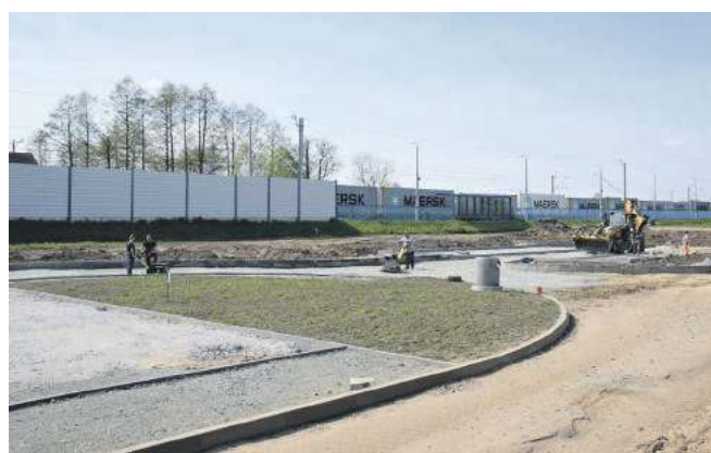
Budowa parkingu typu parkuj i jedź (P&R) w Szewcach
