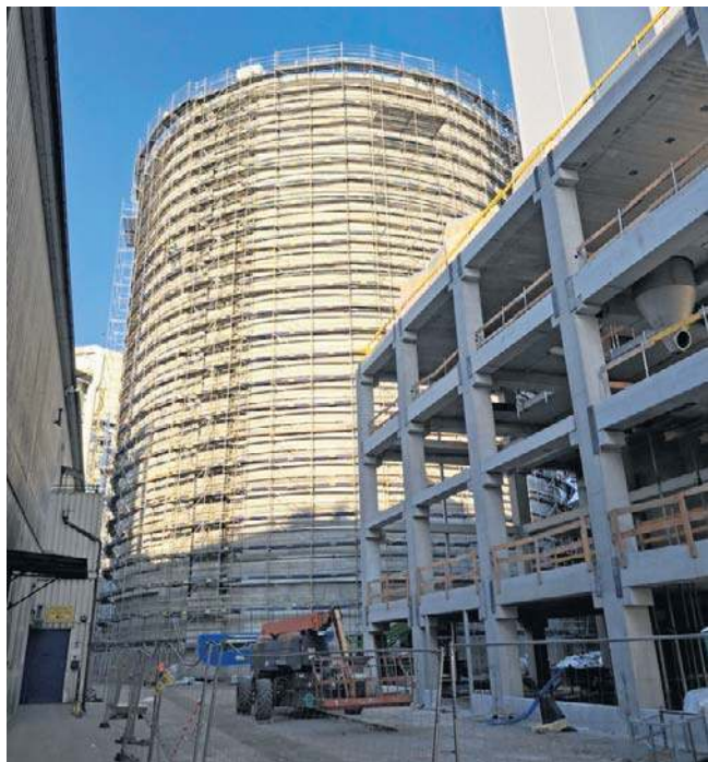
W cukrowni w Kruszwicy trwa budowa nowoczesnego silosu o pojemności 50 tysięcy ton
