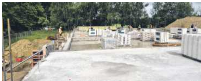
Trwają prace przy budowie nowej szkoły podstawowej
