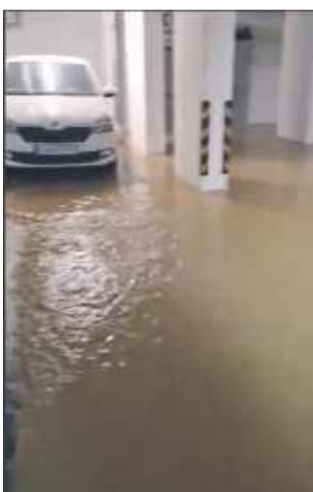
Parking podziemny w Trzebnicy
