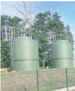
Zakończenie prac przy budowie oczyszczalni ścieków i sieci kanalizacji sanitarnej ma ogromne znaczenie dla mieszkańców Starej Róży (fot. Gmina Stoczek Łukowski)
