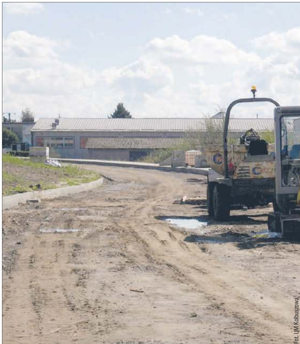
Trwają prace przy połączeniu ul. Ruczki i Wiktora w Kolbuszowej.
