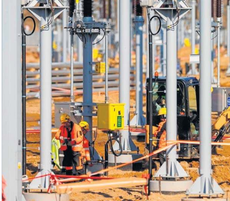
Stacja elektroenergetyczna Choczewo na ostatnim etapie budowy
