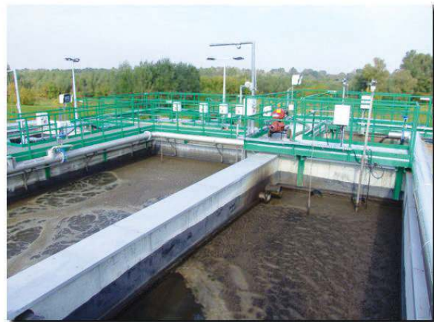
Oczyszczalnia ścieków w Czosnowie
