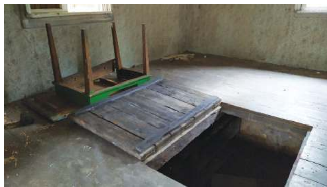
Również meble zostały zniszczone
